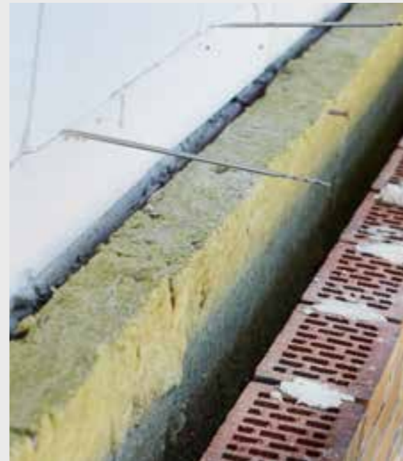
Dämmung im zweischaligen Mauerwerk
