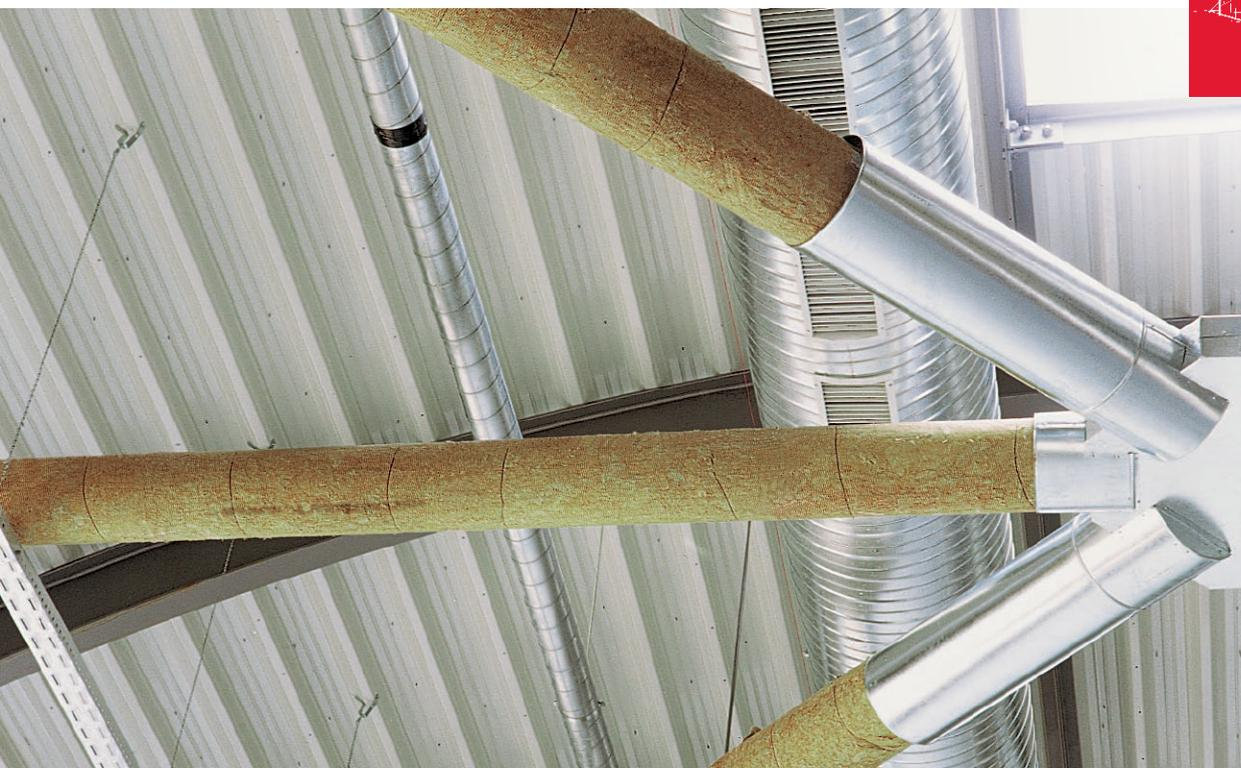
Nichtbrennbare kunstharzgebundene druckfeste Steinwolle-Brandschutzschalen, die vorzugsweise für Brandschutzanwendungen an runden Bauteilen verwendet werden. Sie werden als unkaschierte Variante (Conlit Steelprotect Section) und als mit gitternetzverstärkter Aluminiumfolie kaschierte Variante (Conlit Steelprotect Section Alu) angeboten. Die Conlit Steelprotect Section ist einseitig aufgeschlitzt und zur leichteren Montage auf der Innenwandung eingesägt.
